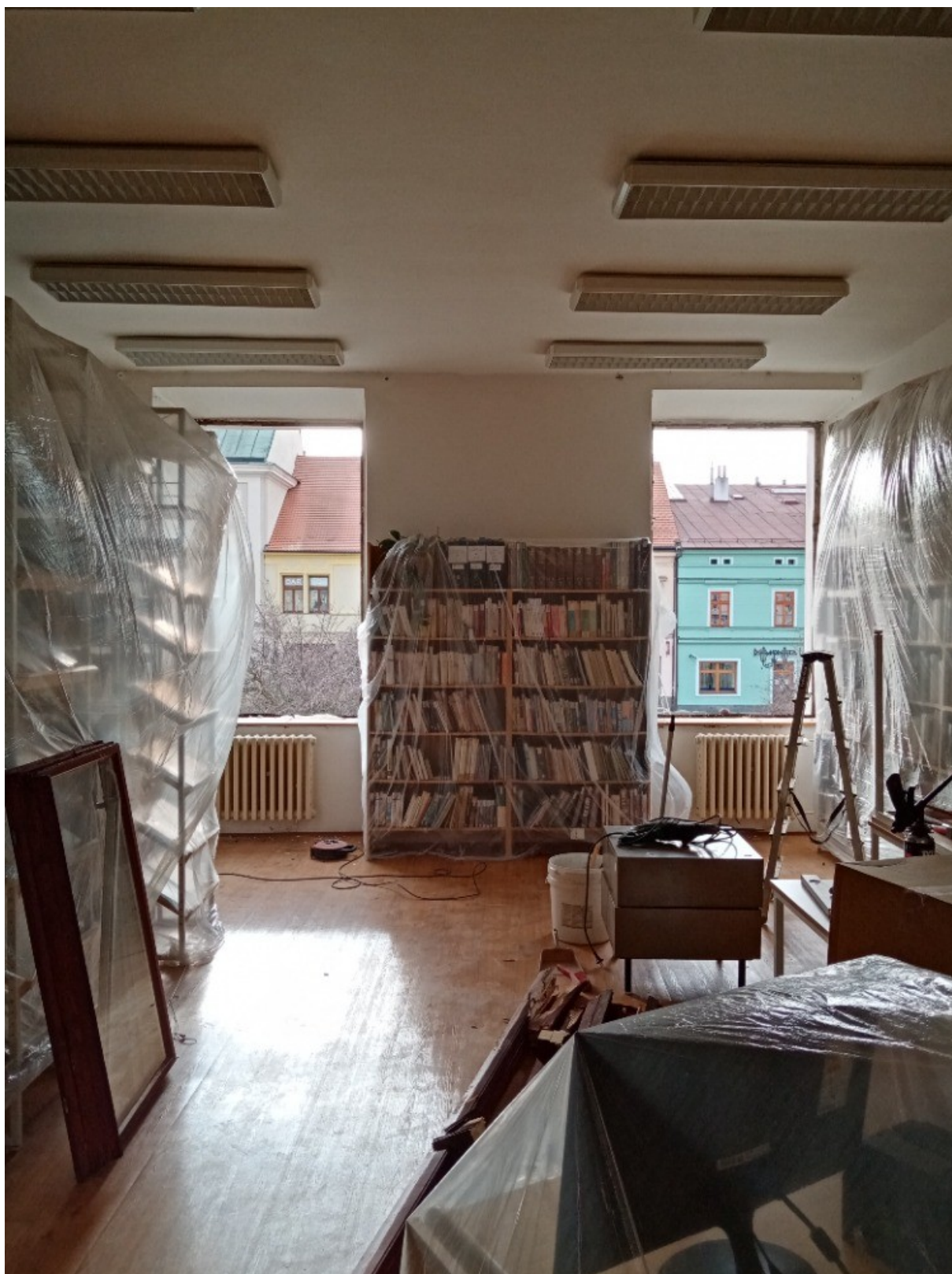
Výměna oken v půjčovně
